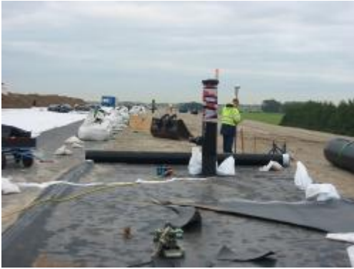
Figuur 3: Afdichtingswerkzaamheden op de stortplaats
